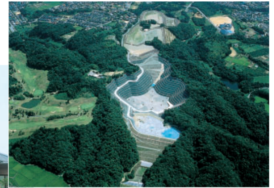
常磐共同火力(株)石灰灰処分場
