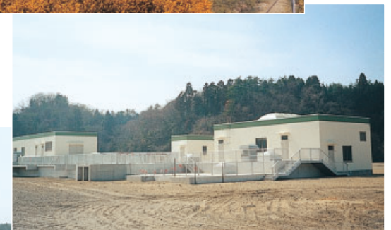
北茨城浄化センター水処理施設
