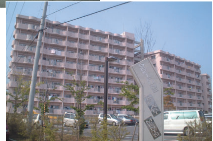
公営住宅関船団地1号棟新築工事
