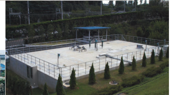
エスエス製薬成田工場排水処理施設建設工事
