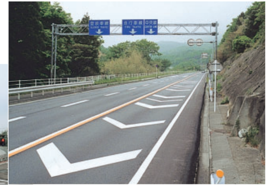
大利舗装修繕工事
