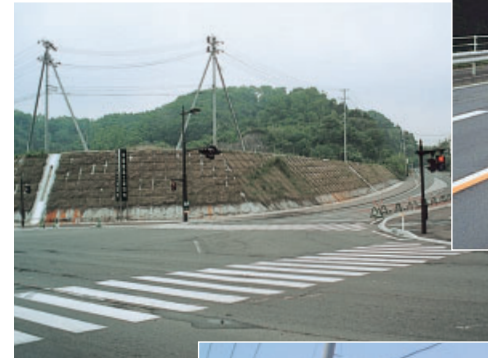
緊急地方道関船・鹿島線整備工事
