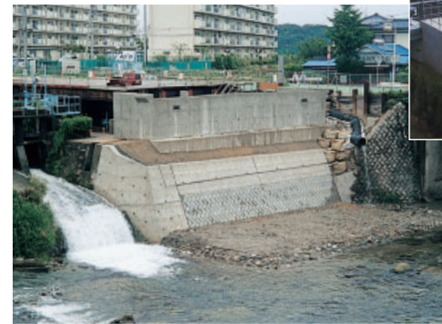
日立・いわき線橋梁下部・護岸工事
