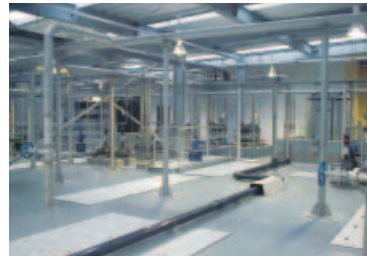
三戸産業廃棄物最終処分場浸出水処理設備工事（青森県）
