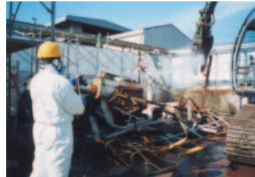
焼却炉解体工事（いわき市）
