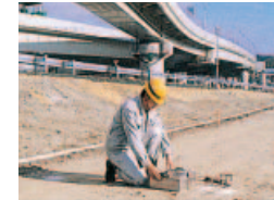
工事現場圧密度試験
