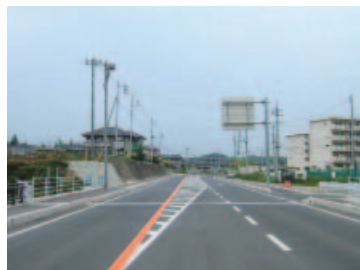
日立・いわき線道路改良工事
