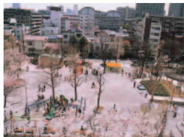
月島児童公園改修工事（東京都中央区）
