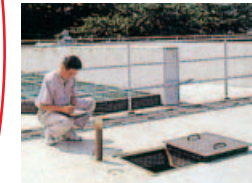
水処理施設管理
