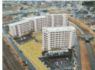
公営関船団地2号棟（第1工区）新築工事（いわき市）
