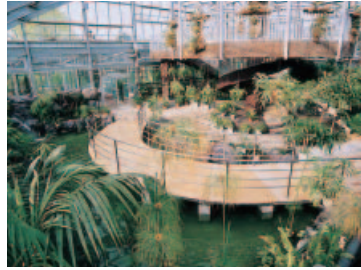
いわき市フラワーセンター高度活用整備事業温室内
