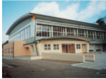
いわき市立内郷第二中学校屋内運動場改築工事
