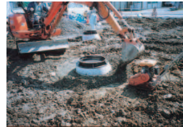
土壌浄化工事（いわき市）
