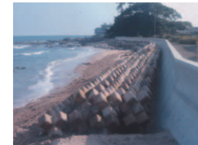
磯原護岸改修（北茨城市）
