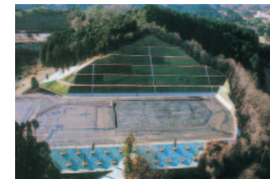
常磐学校給食共同調理場敷地造成（いわき市）
