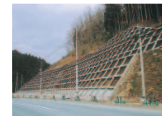
いわき石川線法面（いわき市）
