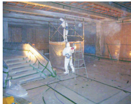
常磐・内郷公民館アスベスト除去工事
