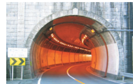
波立トンネル他補強
