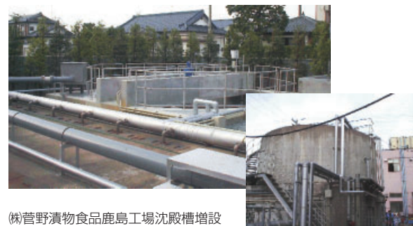
(株)菅野漬物食品鹿島工場沈殿槽増設
