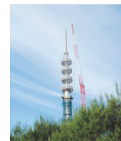
「水戸デジタル送信所電気設備工事」
