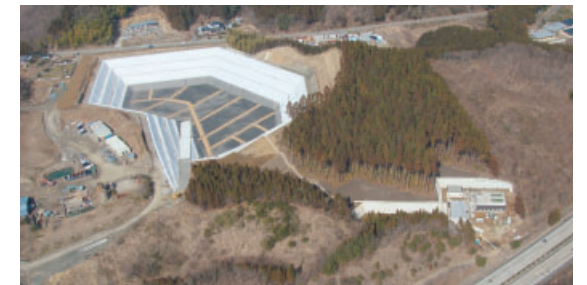
三山クリーン産業廃棄物処分場建設工事
