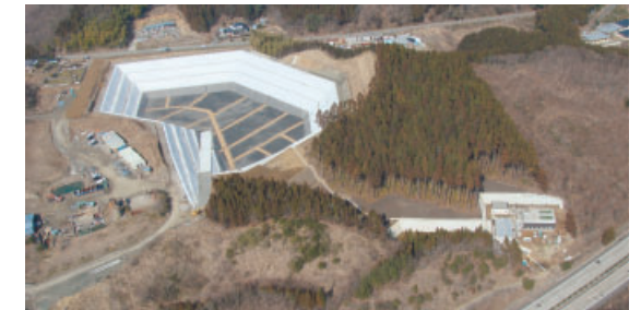
三山クリーン産業廃棄物処分場建設工事
