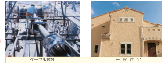
ケーブル敷設
