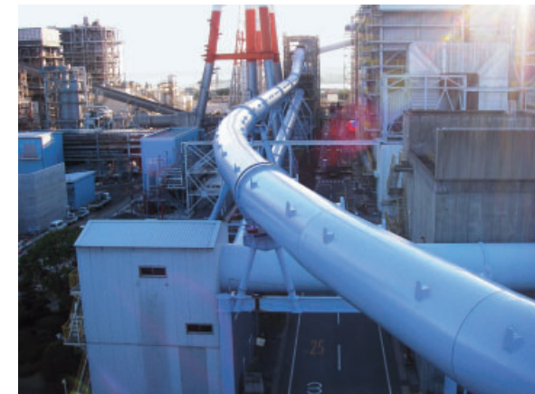
常磐共同火力(株)勿来発電所 「運炭払出コンベア2条化工事」
