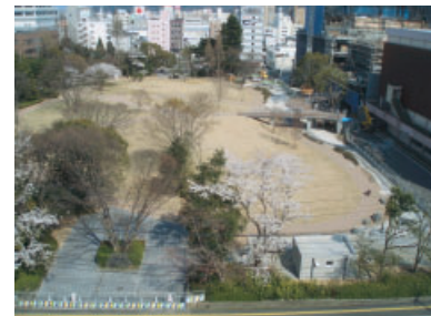
いわき市平中央公園改修工事
