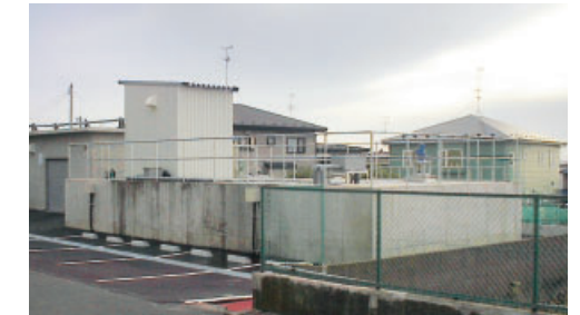
武輪水産(株) 排水処理施設設置工事 (八戸市)
