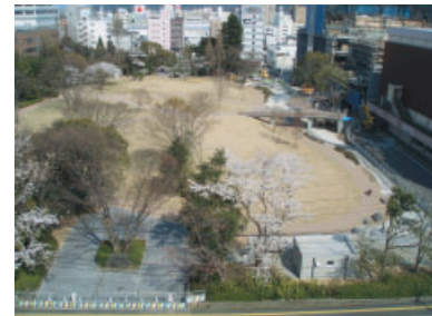
いわき市平中央公園改修工事
