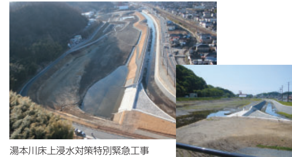
湯本川床上浸水対策特別緊急工事
