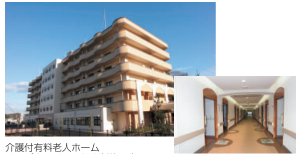
介護付有料老人ホーム メイプルハイムいわき新築工事
