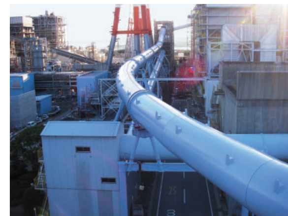
常磐共同火力(株)勿来発電所 「運炭払出コンベア2条化工事」
