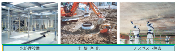
水処理設備 土 壤 浄 化 アスベスト除去
