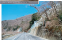
主な完成工事③ 県道いわき石川線公共災害復旧工事（いわき市）
