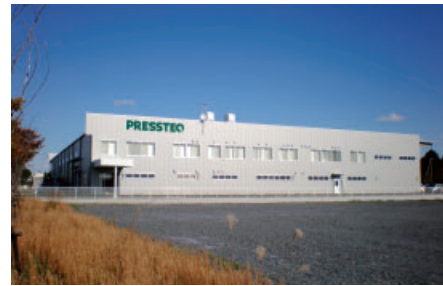
プレステック(株)茨城工場新築工事（茨城町）
