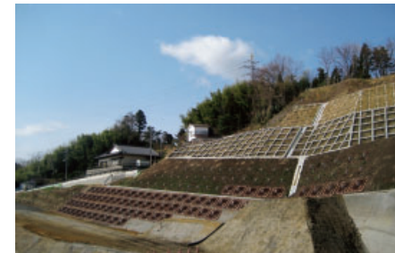
台山水野谷町線道路改良工事
