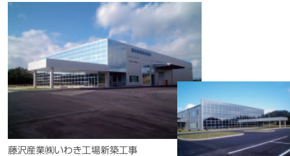
藤沢産業(株)いわき工場新築工事
