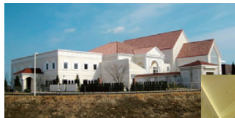
いわきW&P新築工事
