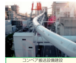
コンベア搬送設備建設
