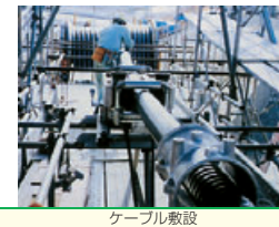
ケーブル敷設
