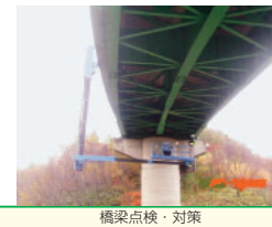
橋梁点検・対策
