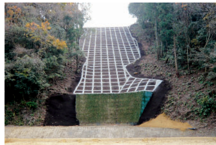
小名浜配水池法面復旧工事
