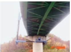
橋梁点検・対策
