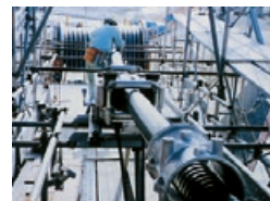
ケーブル敷設
