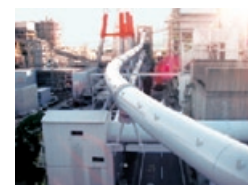
コンベア搬送設備建設
