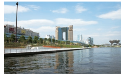
水の広場公園西地区東側整備工事（東京都江東区）
