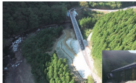
田人町才鉢地内道路応急工事
