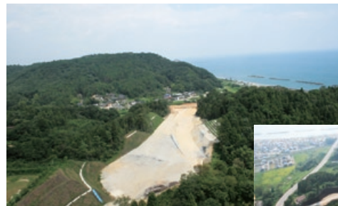
犬松沢地区道路改良工事
