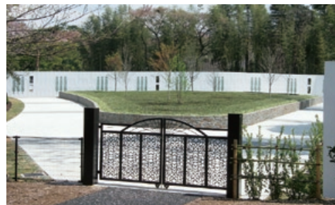
小平霊園整備工事（東京都東村山市）
