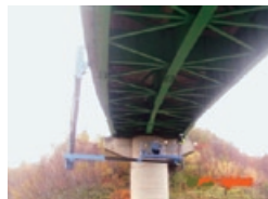
橋梁点検・対策
