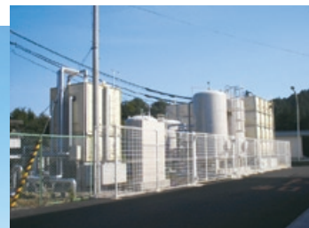
浄化槽増設及び 中水設備工事
