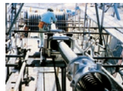
ケーブル敷設
